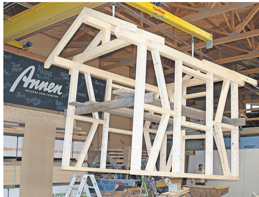
Der Rohbau muss noch finalisiert werden, und dafür bleibt nicht mehr viel Zeit.
